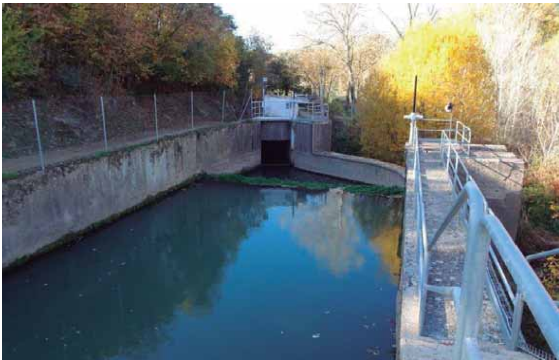
Inicio de la conducción, en el valle del Siurana.
