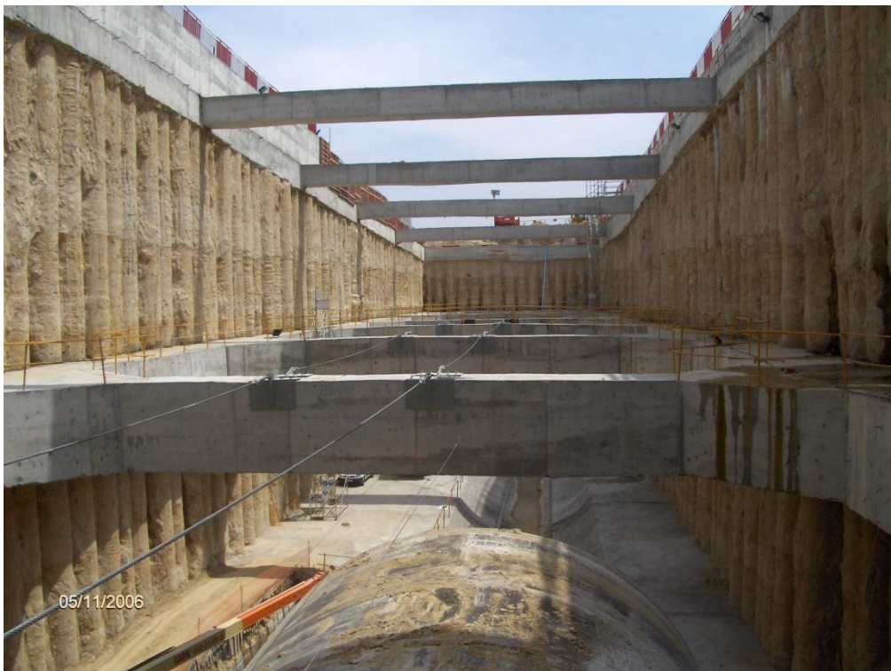
Pozo auxiliar de METRONORTE, vista longitudinal de pantallas de pilotes y estampidores
