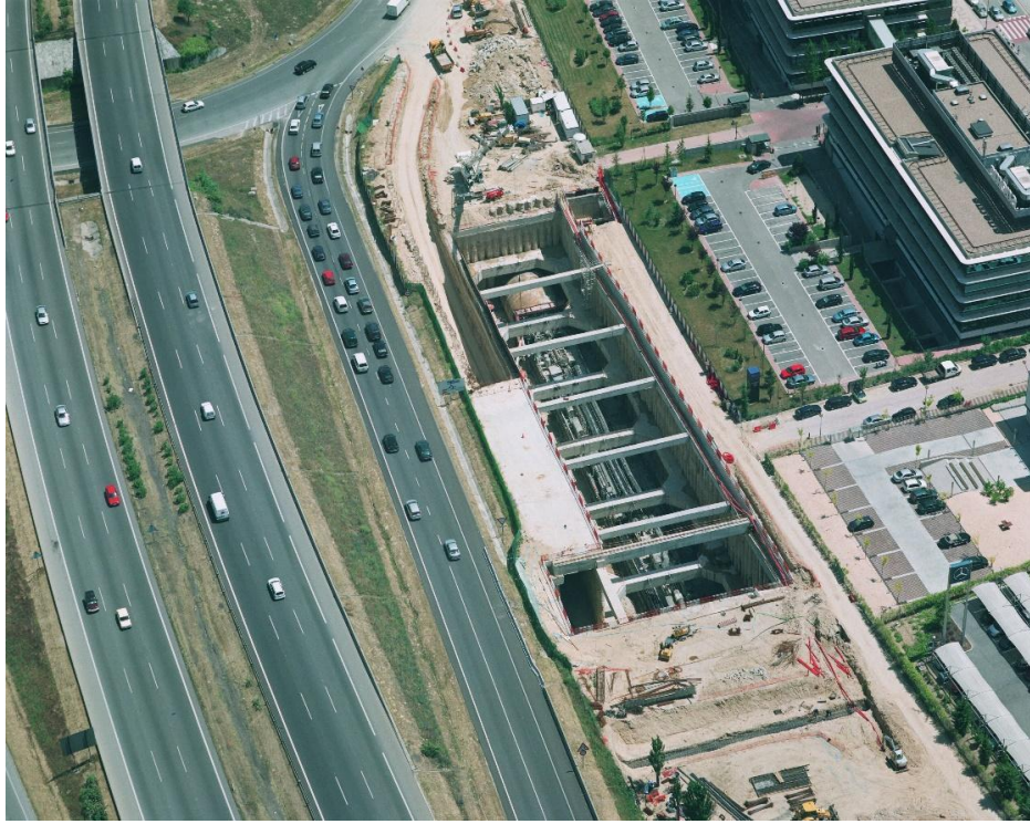
Pozo auxiliar en METRONORTE, vista panorámica aérea.
