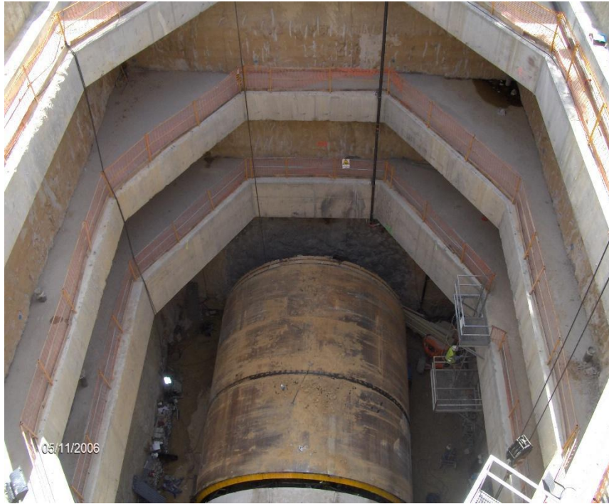
Detalle del pozo auxiliar de METRONORTE, piñón de salida de la tuneladora
