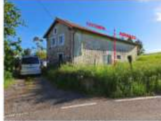
Vista exterior, desde CA-313
