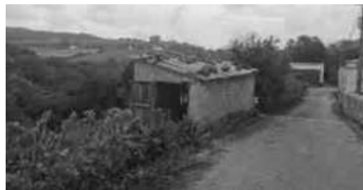
Fotografía caseta de aperos existente en la parcela
