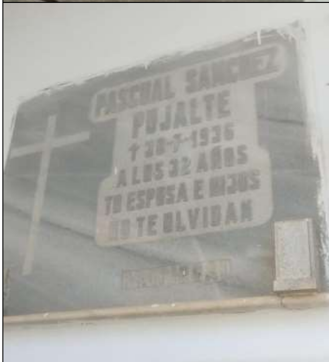
Vista del estado actual del nicho a intervenir. Visita el 27 de febrero de 2024.
