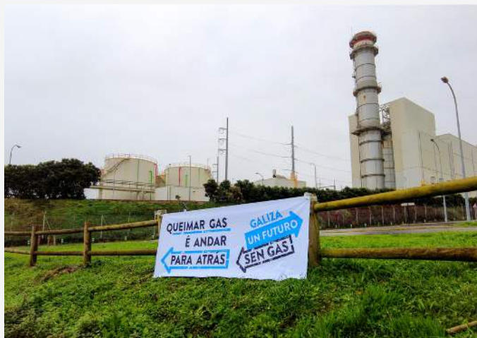
Central eléctrica de ciclo combinado de Sabón (Arteixo). Foto: Galiza sen gas.
