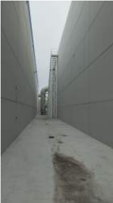
Edificio de biofiltro (dcha). Autor: FRAVM
