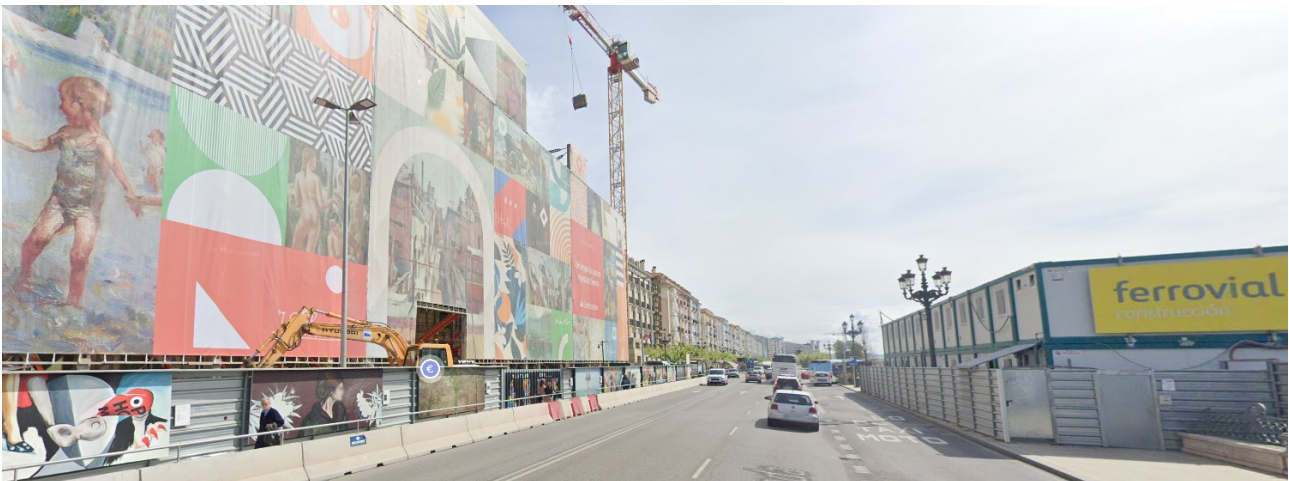
Figura 2: Obras del Banco Santander, ejecutadas por Ferrovial
